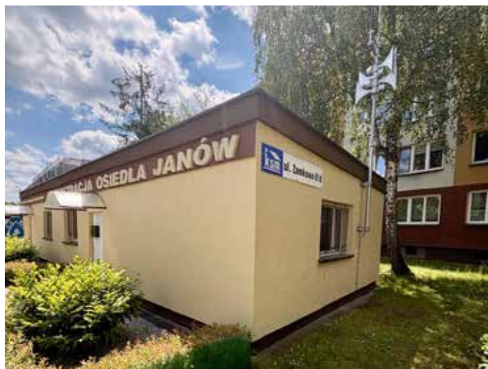
Syrena alarmowa przy siedzibie Administracji Osiedla Janów
