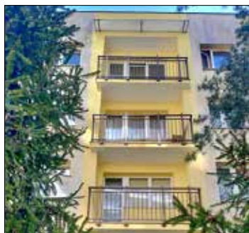
Os. im. F. Ściągły - 40 balkonów po kapitalnym remoncie
