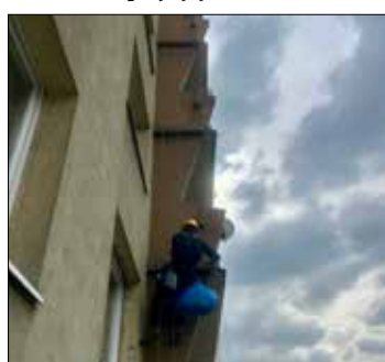
Zawodzie - czyszczono boczne gzymsy przy balkonach
