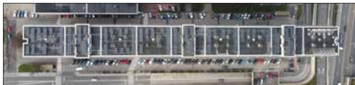
Na dach Superjednostki mieszkańcy przecież nie zaglądają i nie wiedzą, że... jest on wypełniony panelami fotowoltaicznymi
