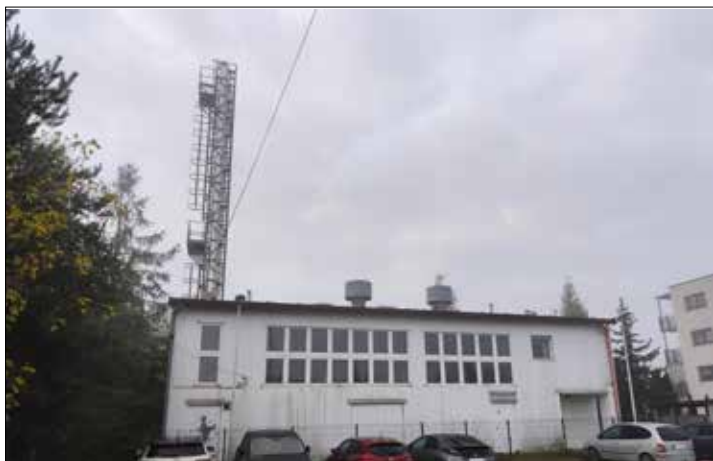
W kotłowni przy ul. Domeyki 14 zainstalowany został nowy kocioł
