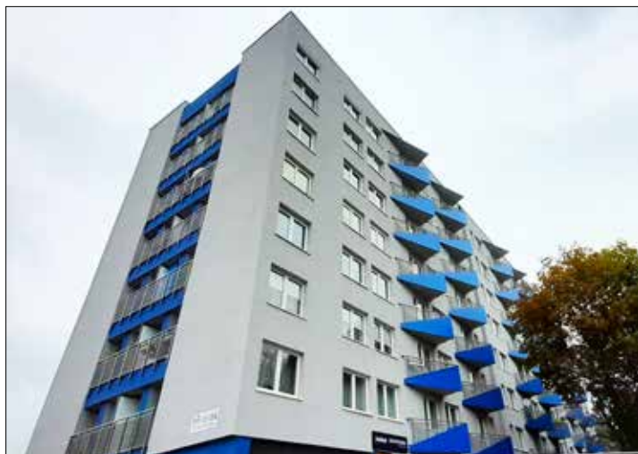
Budynek przy Grażyńskiego 15-15a po termomodernizacji
