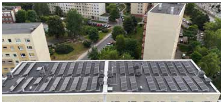
Panele na dachu budynku przy ul. Kurpiowskiej 1-7
