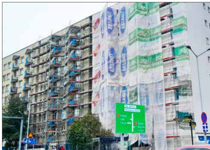
Sąsiadujący przez skwerek budynek przy Sokolskiej 46-48 jest w trakcie termomodernizacji
