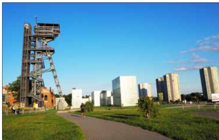
200 lat i współczesność – górnicza wieża szybu „Warszawa” – nowe zabudowania wspaniałego Muzeum Śląskiego – oraz Gwiazdy czyli reprezentacyjne budynki w zasobach Katowickiej Spółdzielni Mieszkaniowej
