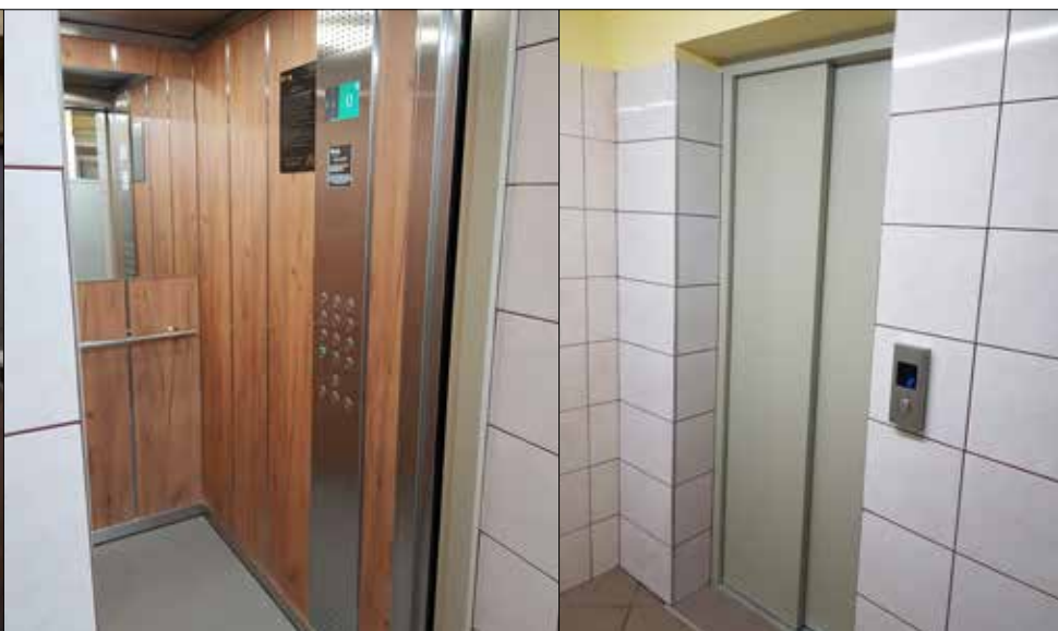
Zmodernizowana winda w budynku przy ul. Osiedlowej 11 w Szopienicach
