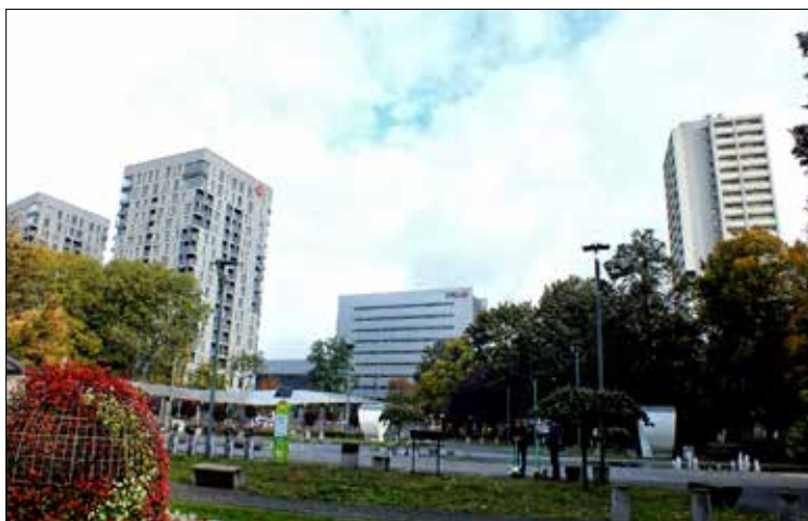
Z okien Sokolskiej 33 można zaglądać w okna Sokolskiej 30. Budynki oddziela tylko jezdnia i dwa chodniki
