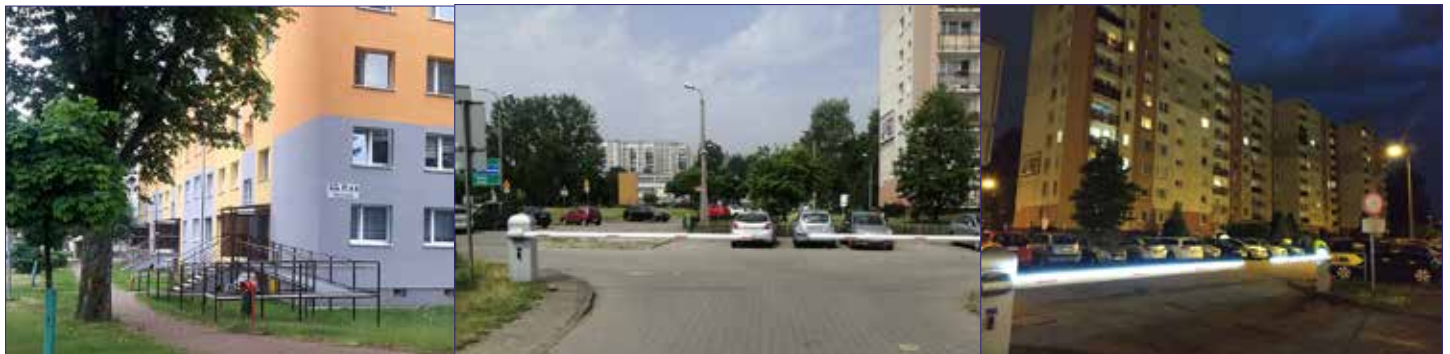
Osiedle Giszowiec: budynek przy ul. Wojciecha 27a-b zyskał nową elewację i podjazd
