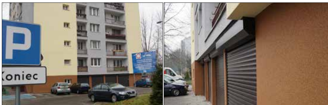
Garaże na Giszowcu po wymianie drzwi
