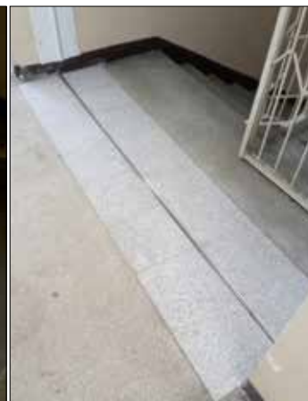
Dylatacje: stara pęknięta (z lewej) i nowa przy ul. Uniwersyteckiej 25
