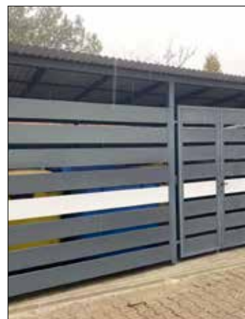
Wiata w Ligocie nad pojemnikami na posegregowane odpady
