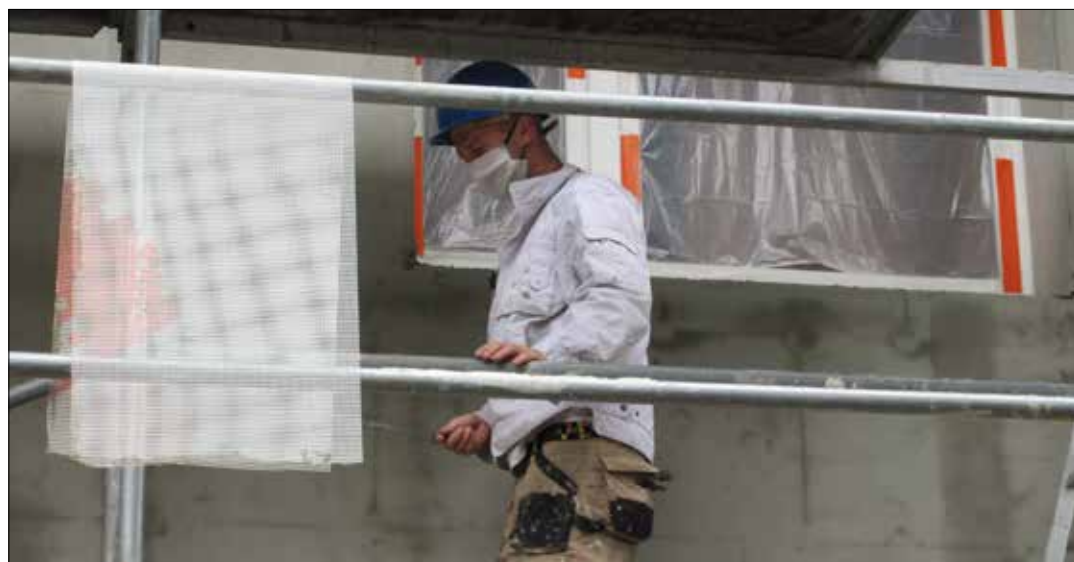
Prace elewacyjne na osiedlu im. J. Kukuczki
