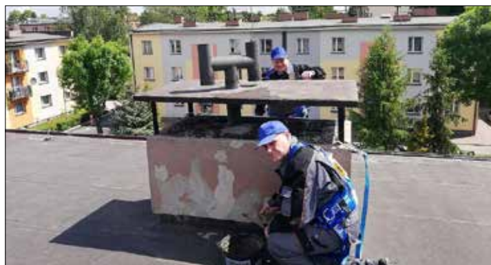
Osiedle Murcki – prace na dachu
