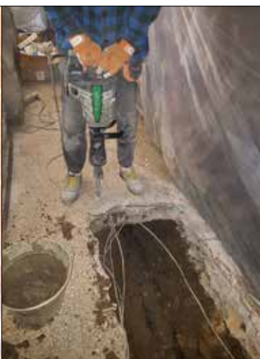
Kompleksową wymianę instalacji sanitarnej przy ul. Karliczka w Giszowcu prowadzą osiedlowi konserwatorzy
