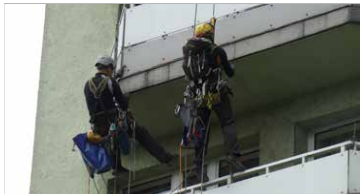
Osiedle Gwiazdy – prace na wysokościach
