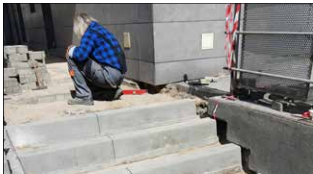
Montaż schodów przy Haperowcu, ul. Sokolska 33
