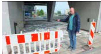
Superjednostka - podziemne garaże już nie będą zalewane
