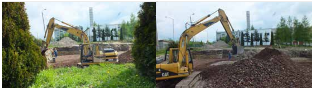
Budowa jest tak prowadzona, by nie zniszczyć istniejącej zieleni
