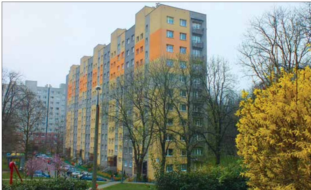
Budynek na Giszowcu, przy ul. Wojciecha 45-45d, nie tylko został wyprostowany, ale także ma już za sobą docieplenie i urządzoną małą architekturę swego otoczenia
