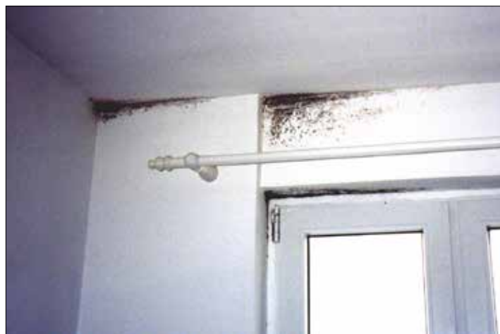
Na wiosnę, po okresie grzewczym, w nabytym uszczelnionym mieszkaniu pojawiło się zagrzybenie
