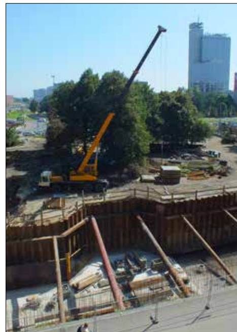
Tam, w dole, będzie przebiegała jezdnia ulicy Śródmiejskiej
