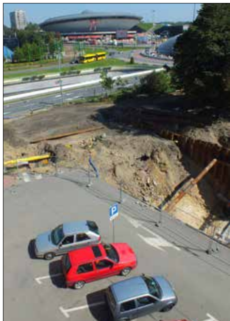
Budowa ul. Śródmiejskiej – w głębi Rondo i Spodek
